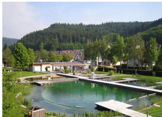
Obrázek 5 Celkový pohled na koupaliště v Sulz (foto: R. Wagner, 2011)
