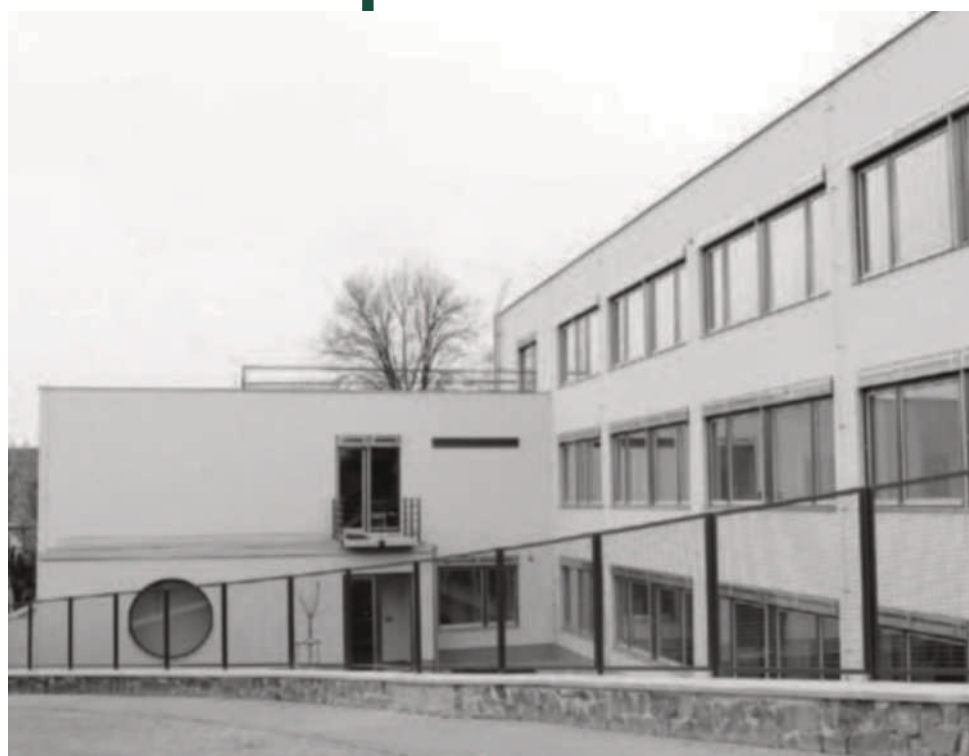
Exteriér rekonstruovaného Morávkova pavilonu, 2012
