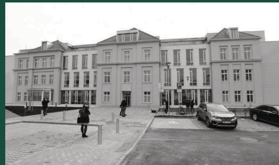
rekonstruovaný Bakešůvpavilon, Ing. arch. Vladislav Vrána, 2021
