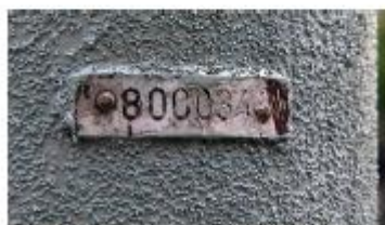
Obr.: Identifikace veřejného osvětlení
