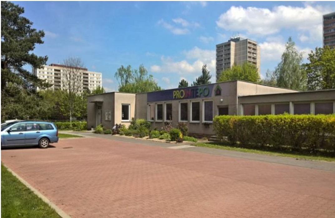
Obrázek č. 1 - Budova Centra Prointepa (Centrum Prointepo, 2008, online)
